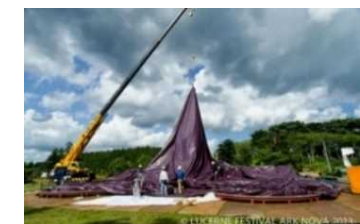
設置中の様子
